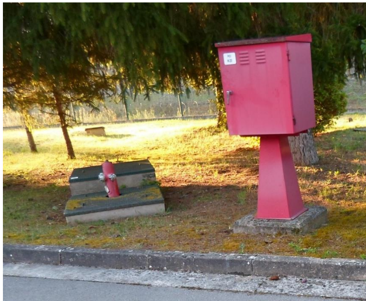
Figura 8-3: Arqueta hidrante H-20, válvula V-25-707 y armario material hidrante.
