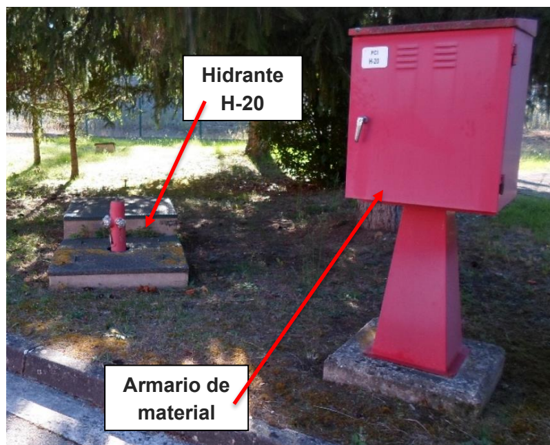
Figura 4-6: Equipos de PCI.
